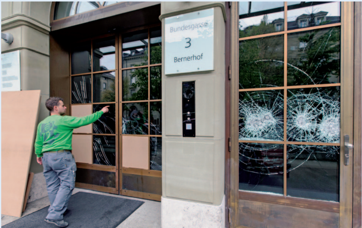
VANDALISME. Les vitres de l'entrée du Bernerhof brisées en marge de l'action «Tanz dich frei», à la fin mai 2013 à Berne. (PHOTO KEYSTONE)
