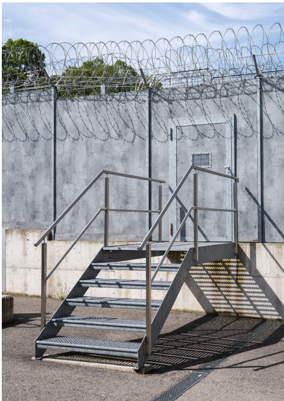
Sur cette photo, on aperçoit le secteur extérieur de l'établissement de détention La Promenade, à La Chaux-de-Fonds (EDPR), où l'artiste Laurence Rasti a réalisé son projet « Un mur comme horizon » en 2024. Photo : Laurence Rasti
