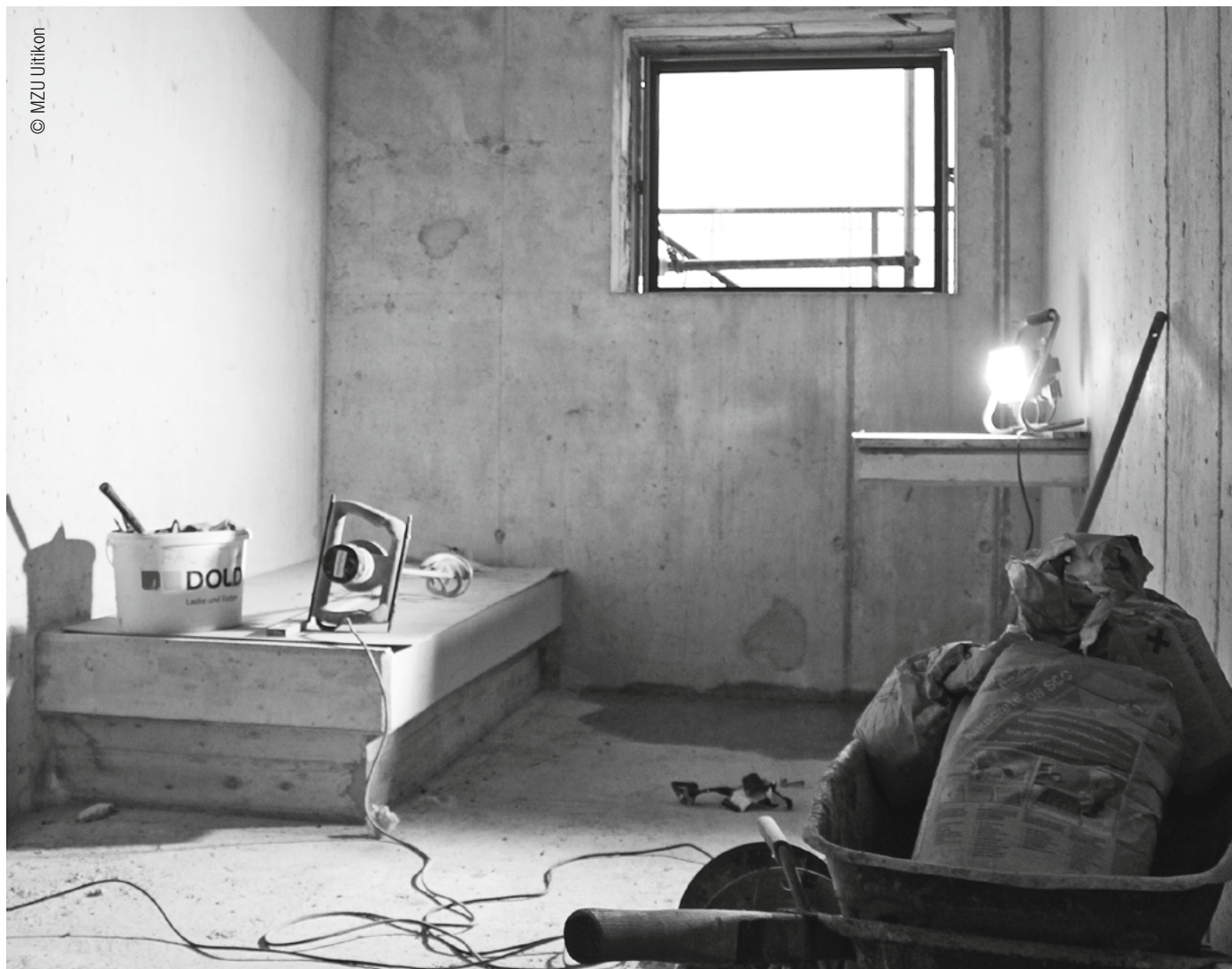
En construction: centre de mesures à Uitikon (ZH). Le nouveau bâtiment sera achevé en 2014. Ici: une nouvelle cellule d'arrêt.
