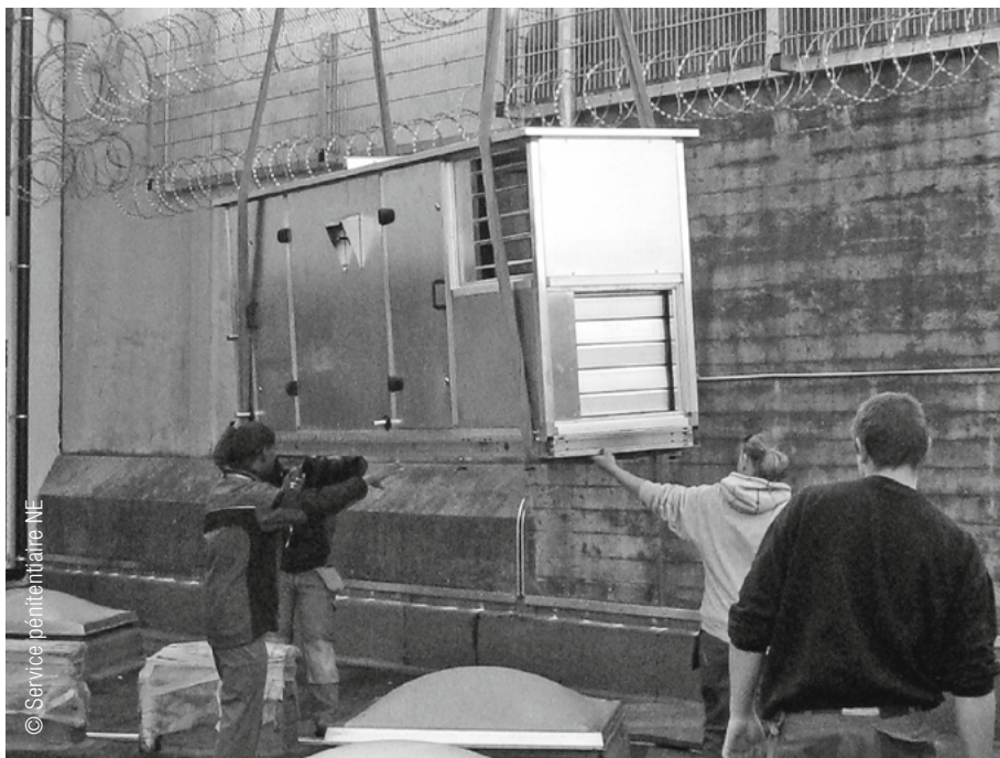
En construction: prison de La Chaux-de-Fonds. L'établissement La Promenade couvre toutes les formes de privation de liberté. Ici: des travaux de montage réalisés dans le cadre de la rénovation.
