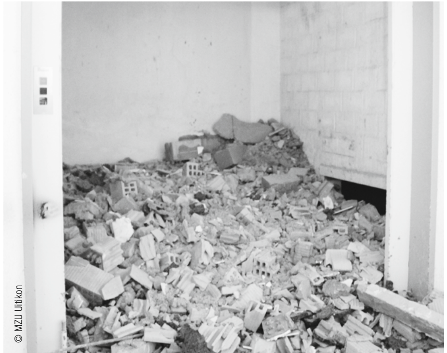
En construction: centre de mesures à Uitikon (ZH). Lors des travaux de construction, l'exploitation de l'institution doit se poursuivre. Ici: une cage d'ascenseur.
