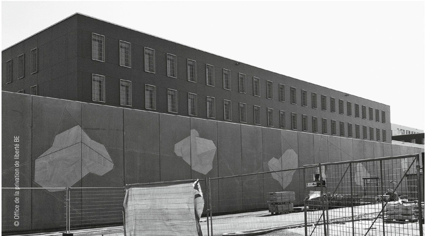
En construction: prison régionale de Burgdorf. Le nouvel établissement, ouvert ce printemps, dispose de 110 places. Ici: peu avant la mise en exploitation.
