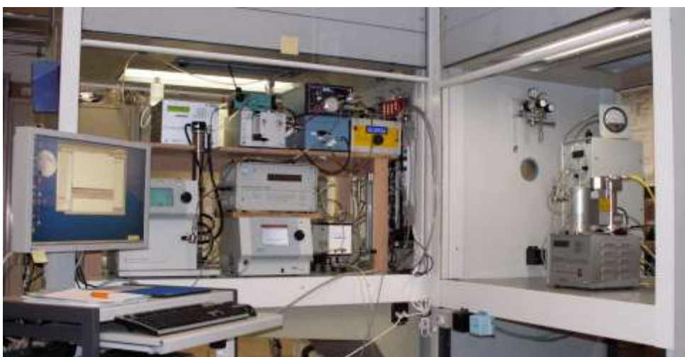
Abbildung 1 Ansicht auf zwei Kapellen (Nr. 1 links, Nr. 2 rechts)
