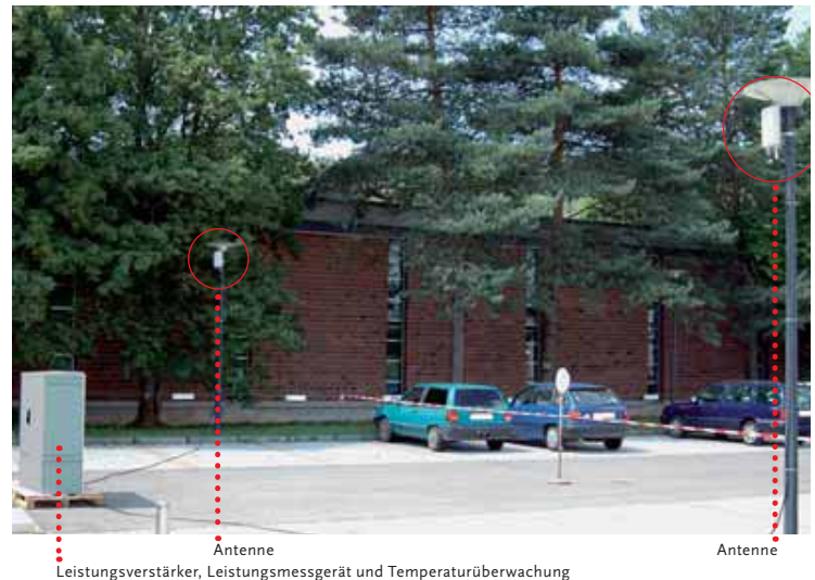
1 Blick auf den Verstärkerkasten und die beiden Antennen vor Raum 1.
