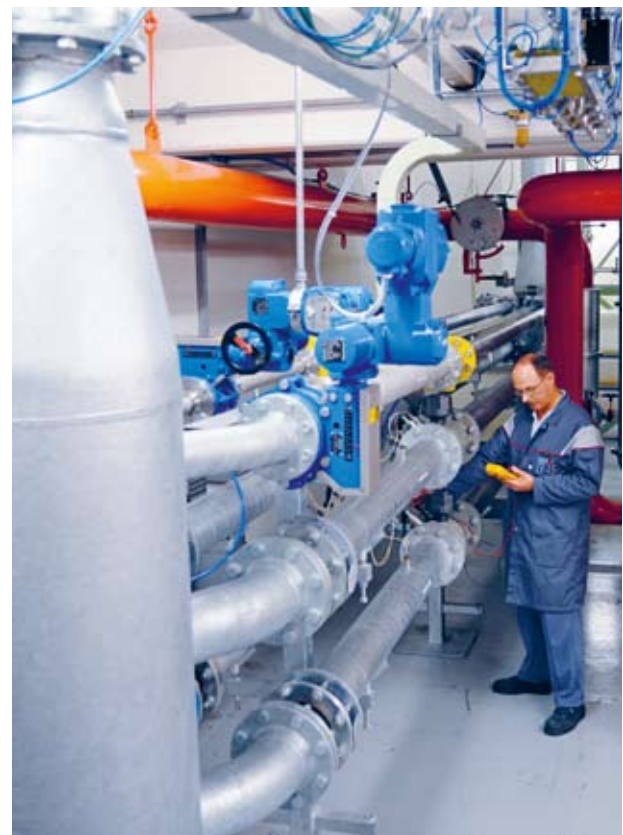
1 Mit den sechs Turbinenrad-Gaszählern (Sekundärnormale) ist METAS in der Lage, Gaszähler mit Durchflussraten von 0.1 m 3 /h bis 4500 m 3 /h Luft in der erforderlichen Genauigkeit zu kalibrieren.
